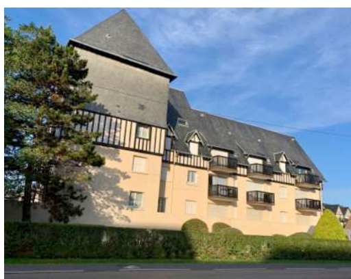
Immeuble de plus de 10m de haut Rue des Diablotines
